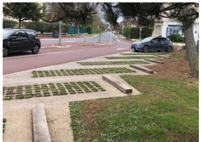
Parkings in ter plaatse gestort beton met drainageopeningen ©ViaVerde
