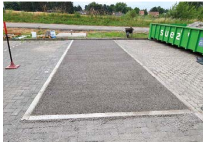
Proefvak met poreuze betonverharding op de OCW-terreinen in Sterrebeek ©OCW
