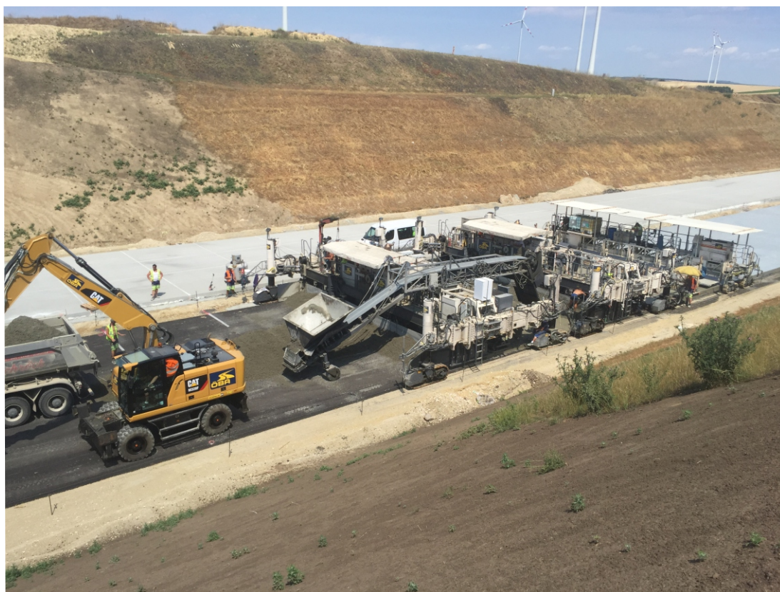
Aanleg van autosnelweg in tweelaags platenbeton in Oostenrijk © Smart Minerals GmbH
