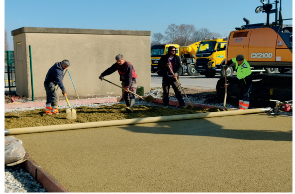
Aanleg van okerkleurig waterdoorlatend beton te Gent.
