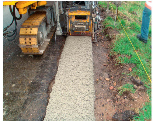
Aanleg van Bermcrete in Nederland
