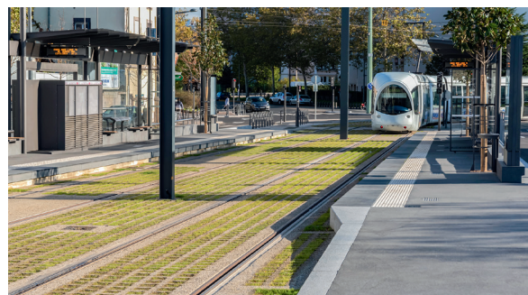
Toepassing van ter plaatse gestort gewapend beton met wafelstructuur voor een parking en trambaan © Viaverde
