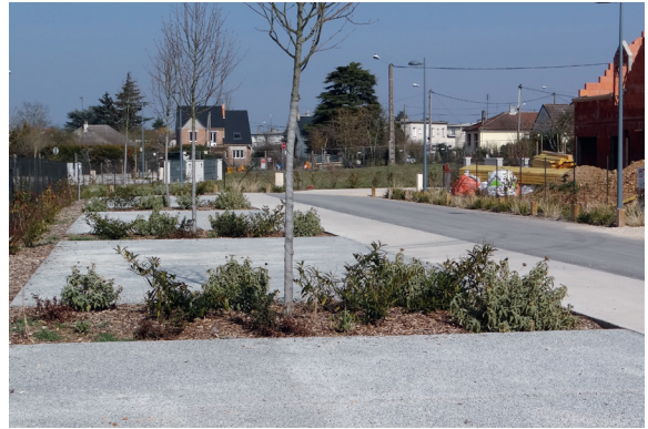
Parking in waterdoorlatend beton. Dreux (Frankrijk) ©Cimbéton
