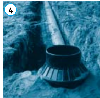
PE inspectieput diameter 1000 mm
