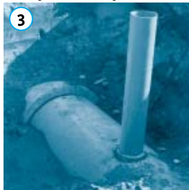
Betoninlaten: uitvoering met rubberdichting
